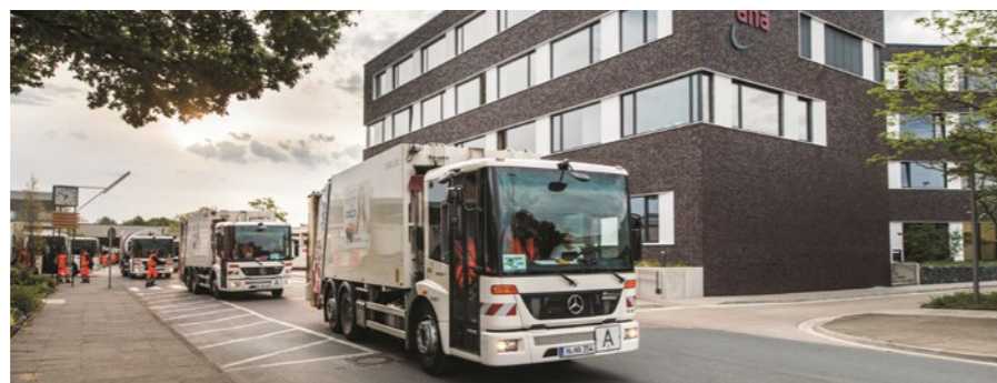
aha-Zentrale im Passivhausstandard
