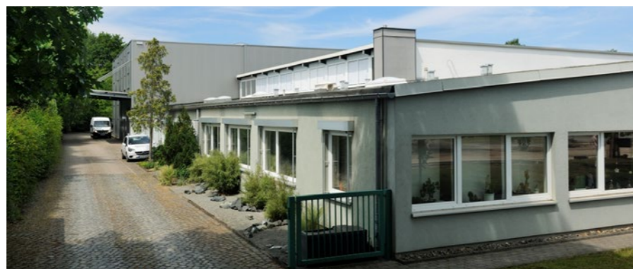
Büro und Lagerhalle
