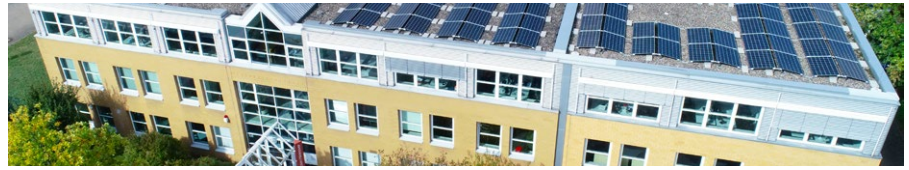
Das Hauptgebäude des Institut für Integrierte Produktion Hannover gGmbH mit Photovoltaikanlage
