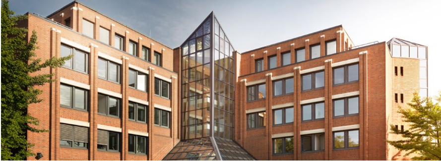
Hauptgebäude der Hannover Rück
