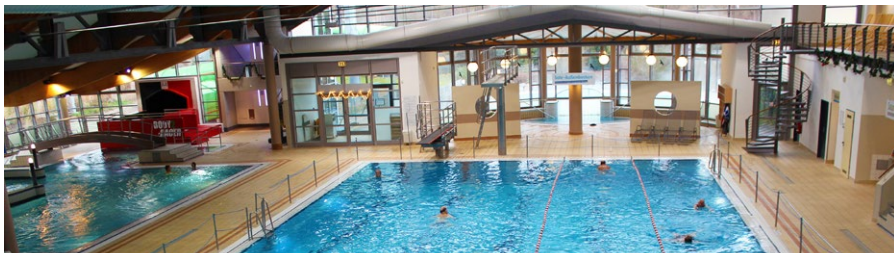
Tageslichtabhängige Beleuchtung in den Schwimmhallen
